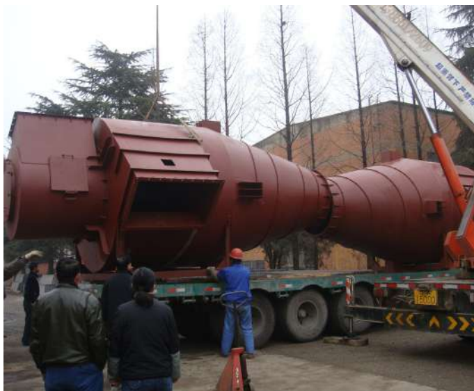
Exhaust dry/wet cyclone separator 尾气干式/湿式旋风分离器
